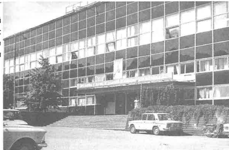
Механо-сборочный Комплекс на Юго-Западе г.Москва
