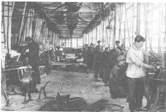
Монтаж импортного оборудования
