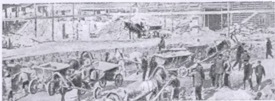
Начало работ на строительстве 2-го часового завода. 1929 год
