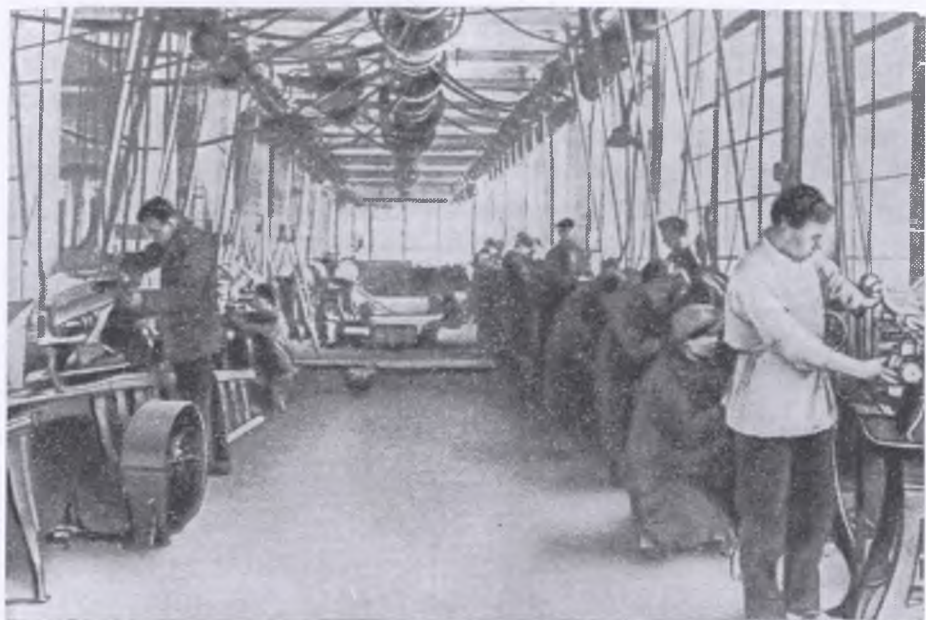
Монтаж оборудования на 2-м часовом заводе. 1930 год
